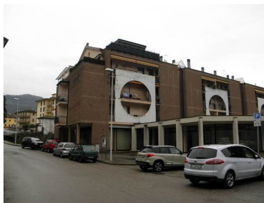
VISTA SUD OVEST
